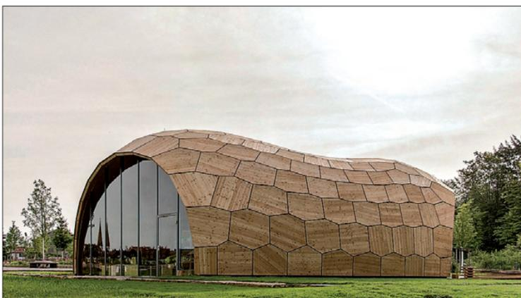
Der am Computer entworfene Forstpavillon besteht aus 5 cm dicken Buchenholzplatten. Er hat äußere Abmessungen von etwa 17 x 11 x 6 m (LxBxH) und eine Schalenfläche von 245 m<sup>2</sup>
