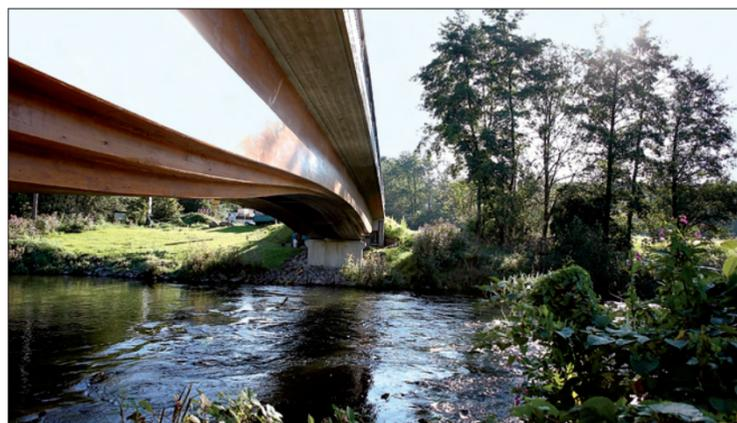
Die neue Holz-Beton-Verbundbrücke in Lohmar ist dreifeldrig ausgeführt, ihr Mittelfeld überspannt 28 m. Die blockverklebten Träger haben eine variable Höhe und abgestufte Unterseiten
